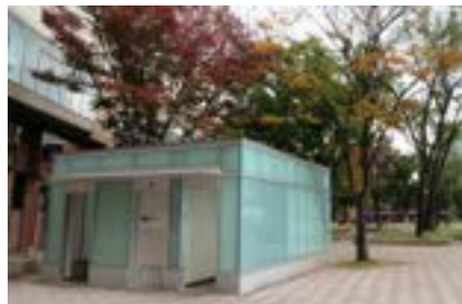
移設されたトイレ
